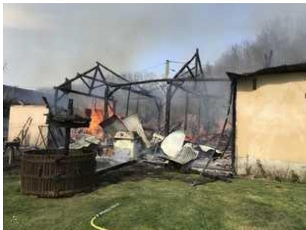
**La disparition ou la déformation des planchers ou des poutres peut compromettre leur stabilité. Ces structures peuvent être fragilisées et mettre en péril la sécurité des secours et la stabilité du bâtiment.**
