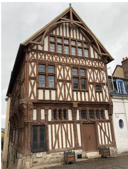
Un mur en pan de bois est une construction établie avec des pièces de bois assemblées entre-elles et un remplissage en maçonnerie, en plâtre, en brique ou en terre.
